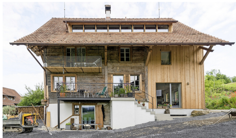
Leicht – und fast wie Körbe ans Haus gesetzt – wirken die beiden neuen Balkons. Der untere ist mit einem barocken Geländer geschmückt.
