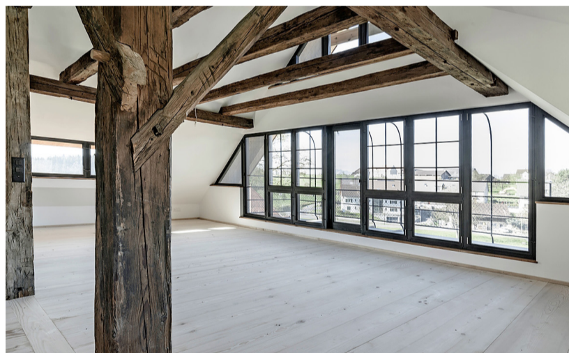
Ehemaliger Estrich: Durch die neue verglaste Giebelwand aus Metallfenstern dringt heute viel Licht in den Raum.
